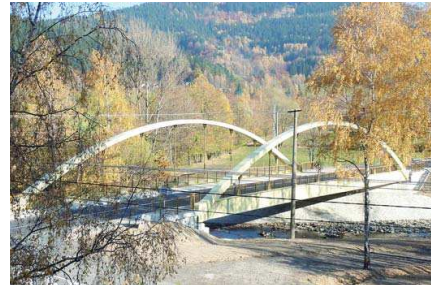
NOVOSTAVBA MOSTU v Morávce je i po architektonické stránce zajímavou stavební dominantou.
