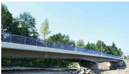
JEDNOU z nejvýznamnějších staveb je rekonstrukce mostu v Bašce přes řeku Ostravici.
